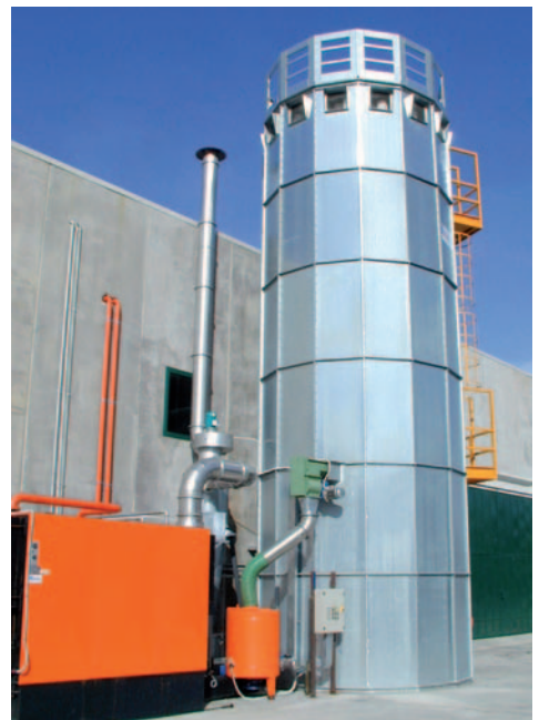
Silos CORAL V con scarico materiale in caldaia Silos CORAL V avec dechargement materiel en chaudiere CORAL V Silo with boiler load Silos CORAL V mit Entladung in Heizkessel Silos CORAL V con descarga del material en caldera
