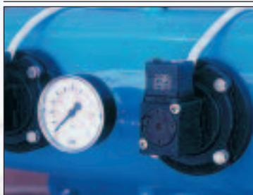
**ELETTROVALVOLA A MEMBRANA:** valvole a due vie normalmente chiuse azionate da solenoide eccitato elettricamente; per aria compressa fino a 7 bar. Pressione nel serbatoio aria compressa: 4/7 bar.
